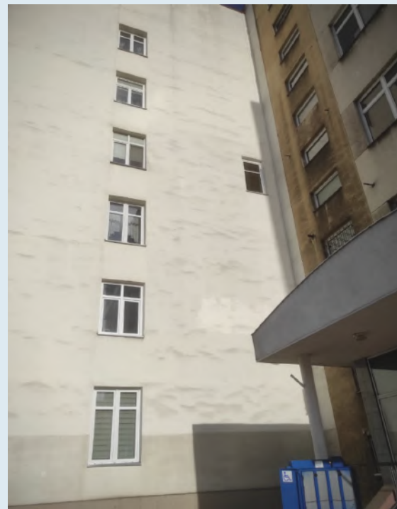
stan istniejący - okno przeciwpożarowe, autor zdjęcia Ateli
